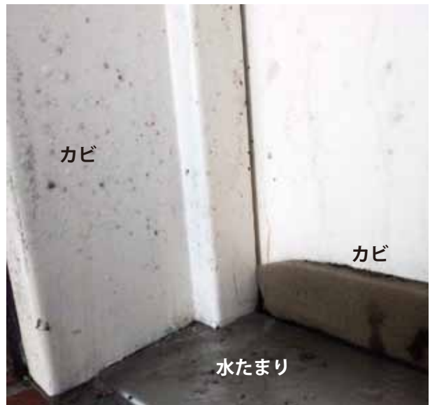
写真 1：収蔵室 3 扉下の結露のしずくがたまった水と付近に発生したカビ
