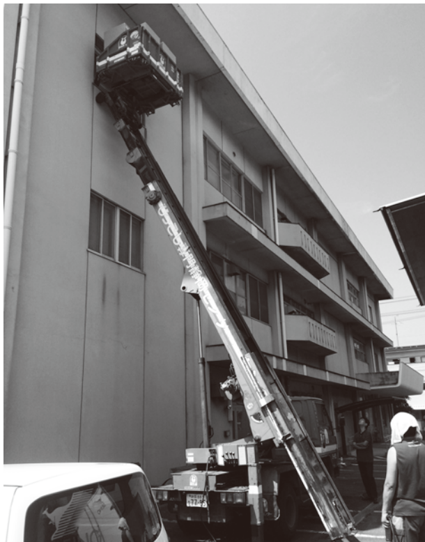
清水分室 3階からリフトで荷物を下ろす
