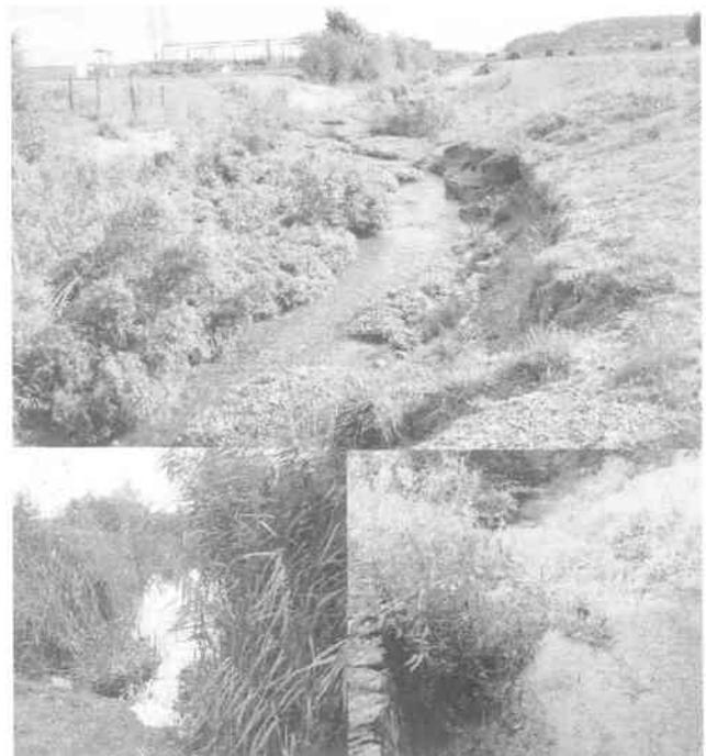
写真3 Chrebsbach は1970年代に農地改良のため掘り下げられてできた水路で、3面に石組み護岸がある。川は自然的に蛇行を形成した。
